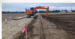
Construire de Drumuri
